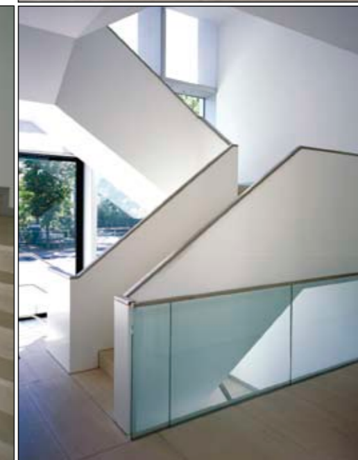
Schön gestaltete Treppe mit interessanten Licht/Schatten-Effekten. Der Natursteinboden wird als Treppenbelag weitergeführt. Das Foto unten zeigt ein schönes Detail vom Auflager der Edelstahlwange
