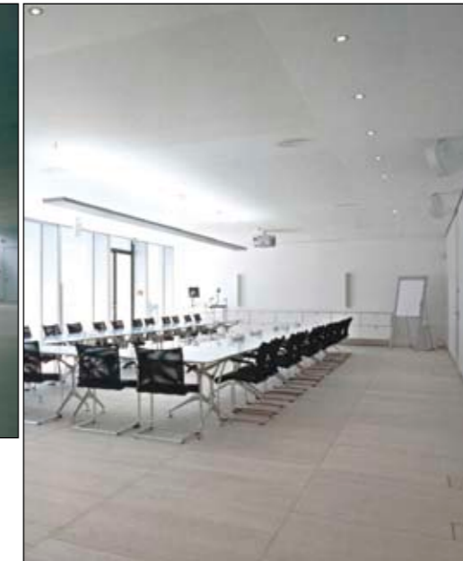
Großer, saalartiger Mehrzweckraum im Untergeschoss. Naturstein in unregelmäßigen Rechteckbänden. Die Bodenplatten sind bis zu 1,80 Metern lang und zwischen 30 und 80 Zentimetern breit, bei einer durchgängigen Stärke von 4 Zentimetern.
