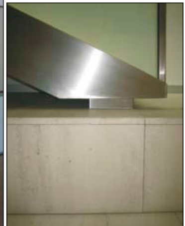
Schön gestaltete Treppe mit interessanten Licht/Schatten-Effekten. Der Natursteinboden wird als Treppenbelag weitergeführt. Das Foto unten zeigt ein schönes Detail vom Auflager der Edelstahlwange
