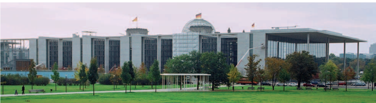
Kammstruktur des Gebäudekomplexes
